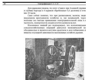
Рис. 5. Колеса с электрическим приводом
